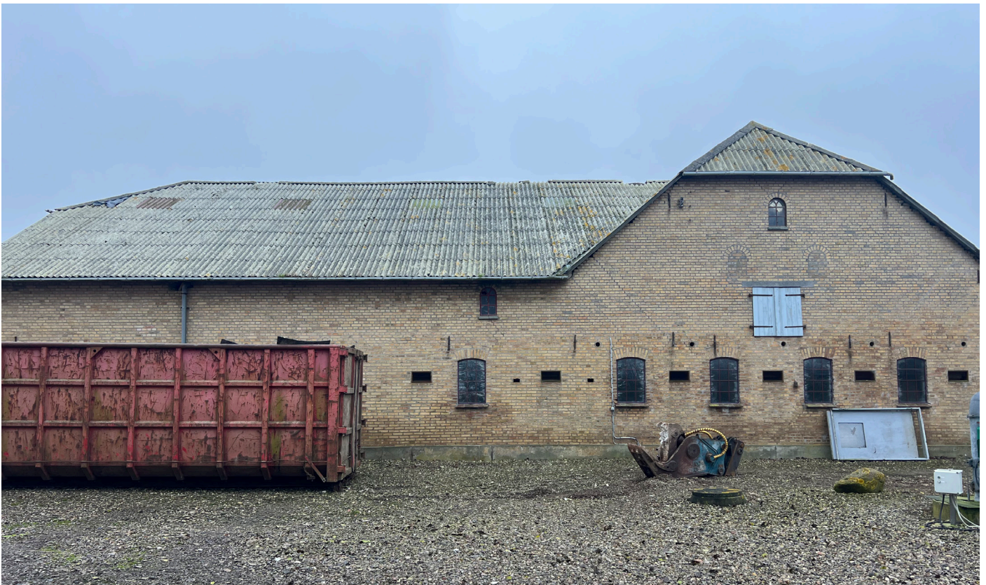
Bygning 2: nord facade
