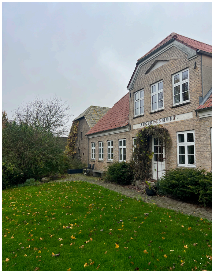
Bygning 2: syd facade
