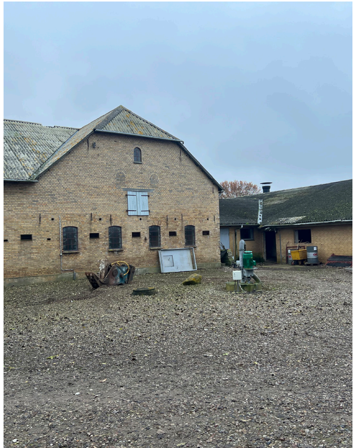
Bygning 2: nord facade
