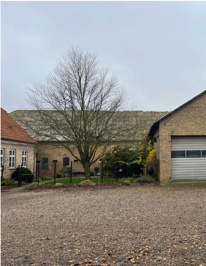
Bygning 2: øst facade og øst gavl
