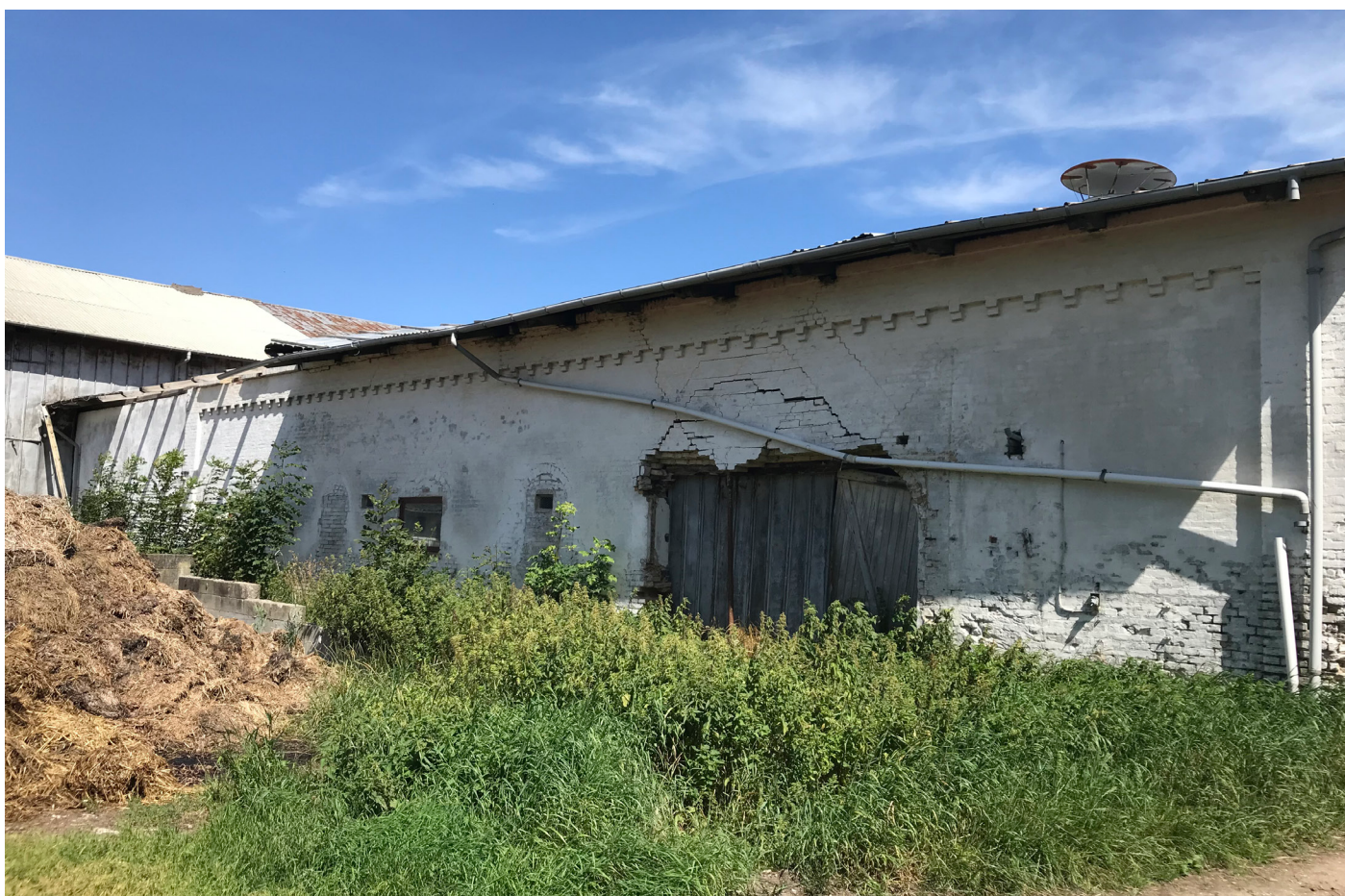
Bygning set fra vest
