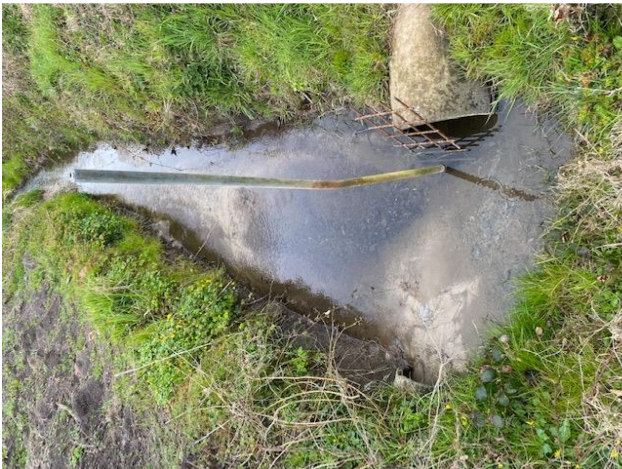
Figur 20: Fra syd kommer det rørlagte vandløb T12, den nuværende rørlagte det af Blommelskobbek Bæk ses som det nordlige rør.
