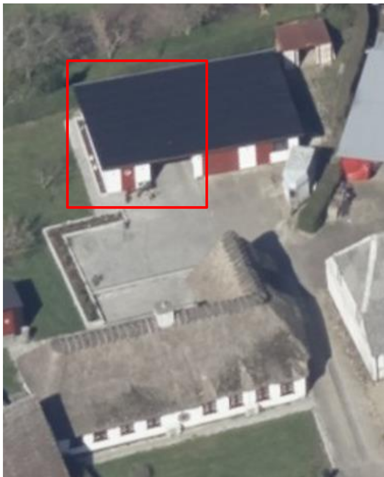
Skråfoto fra 2023 som viser den del af garagen som er blevet udvidet.
