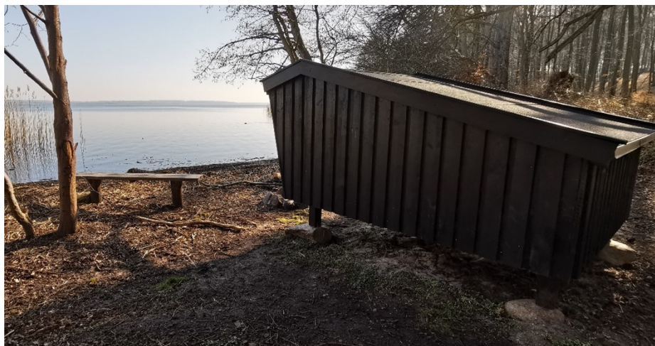
Figur 1 - Mini shelter opsat i Nordsjælland
