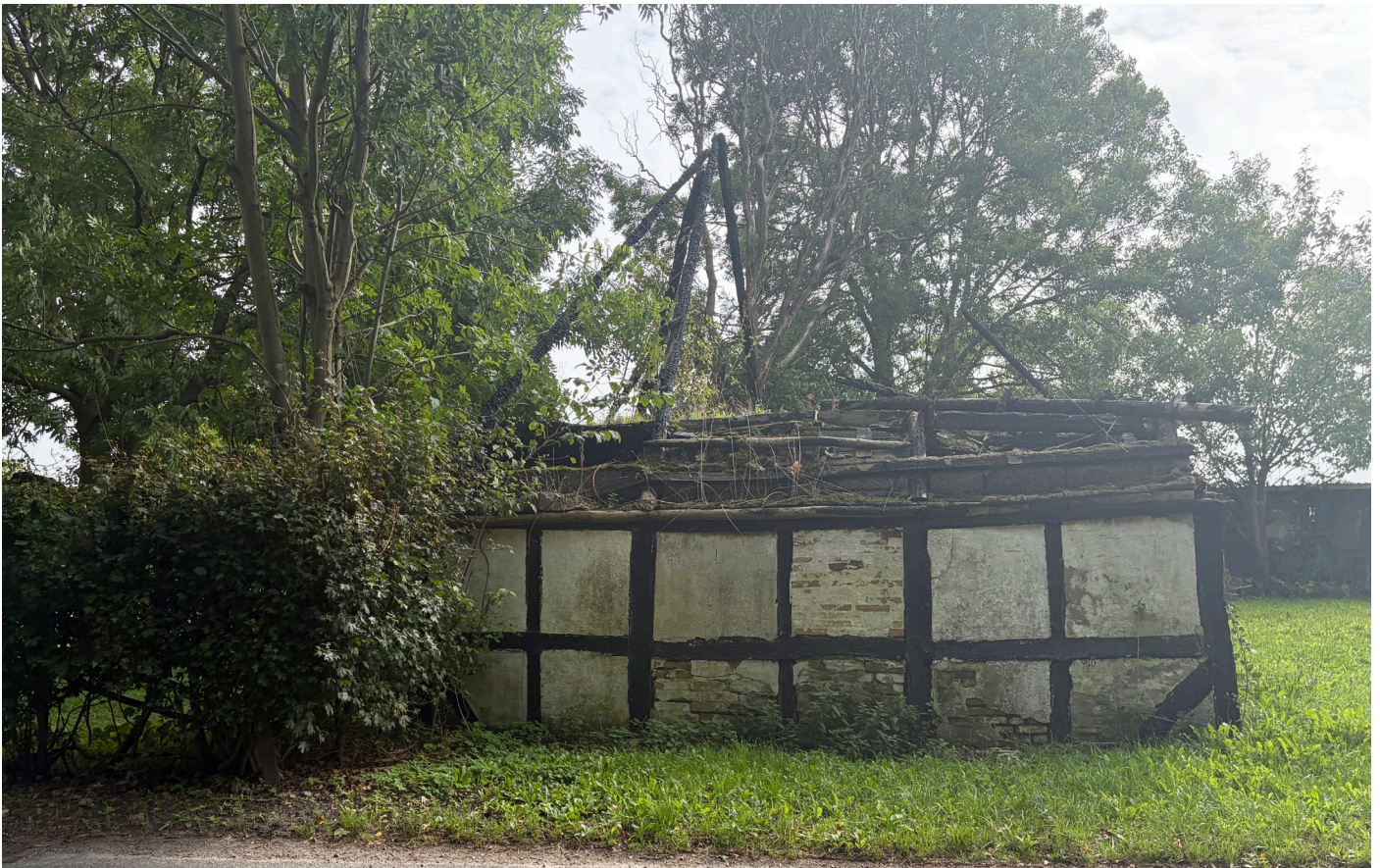
Foto af bygning 7: nord facade.
