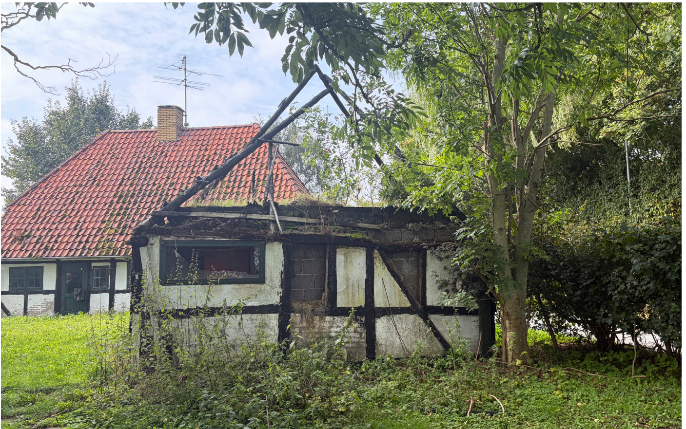
Foto af bygning 7: øst gavl.
