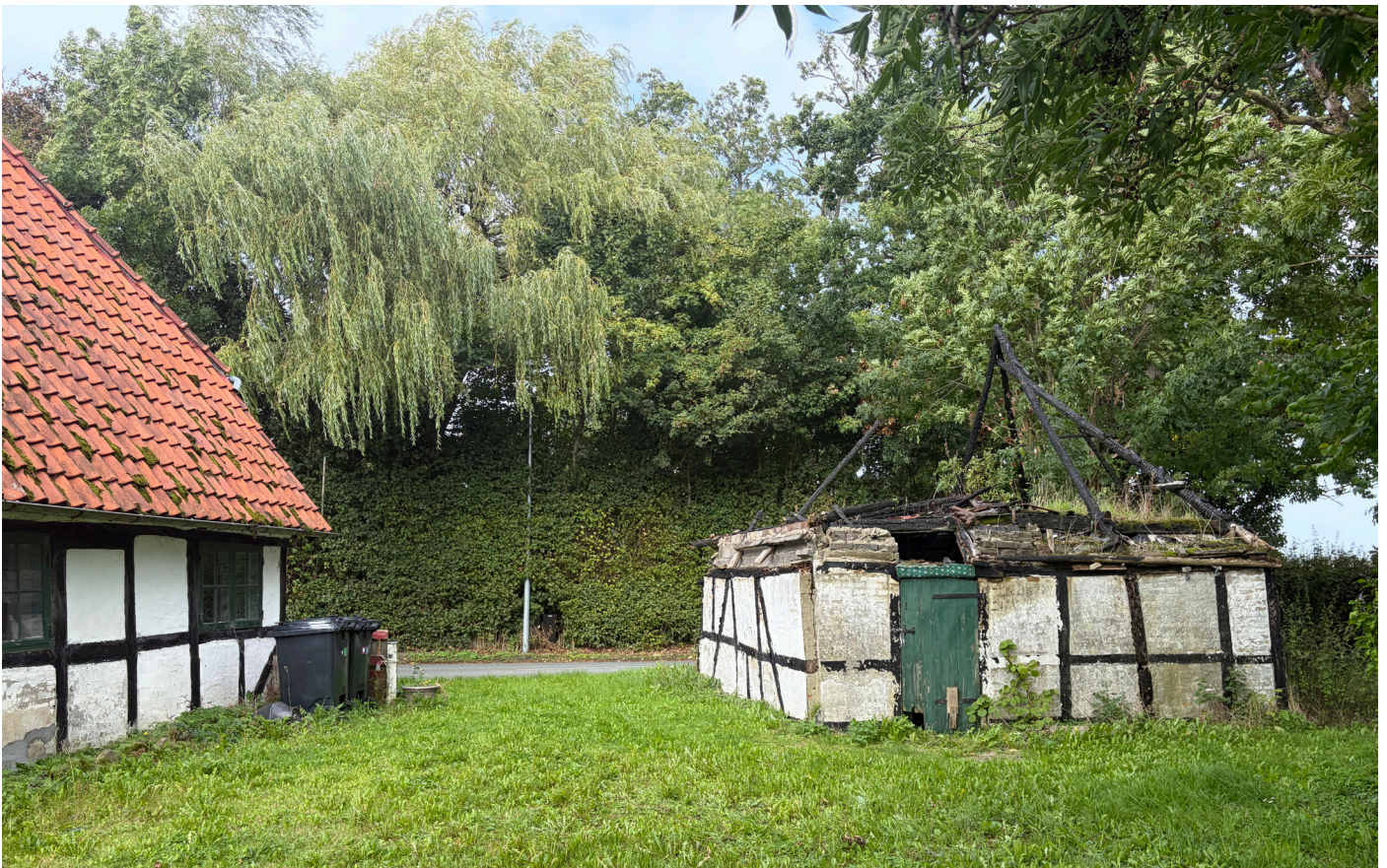
Foto af bygning 7: syd facade.
