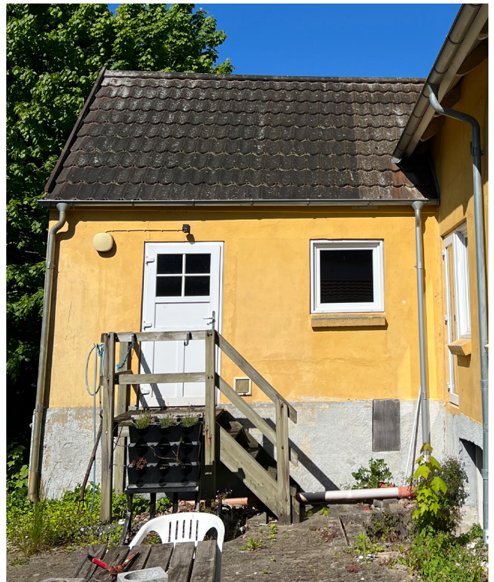
Tilbygning: facade vest.
