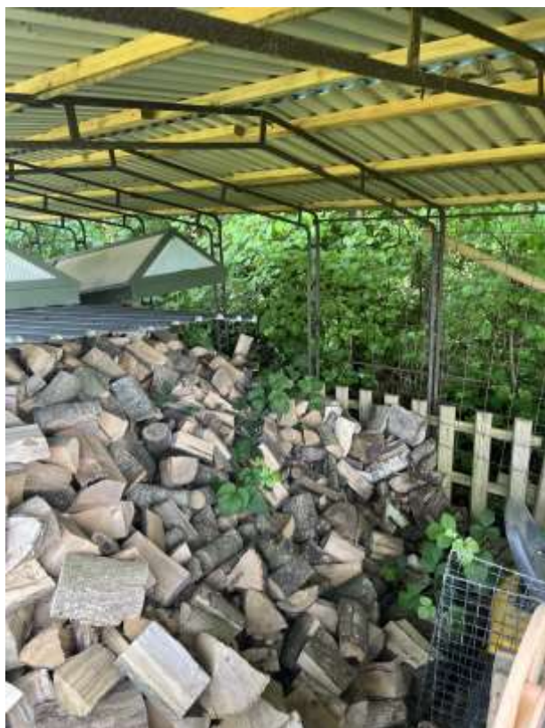
Foto som viser overdækningen indvendig.
