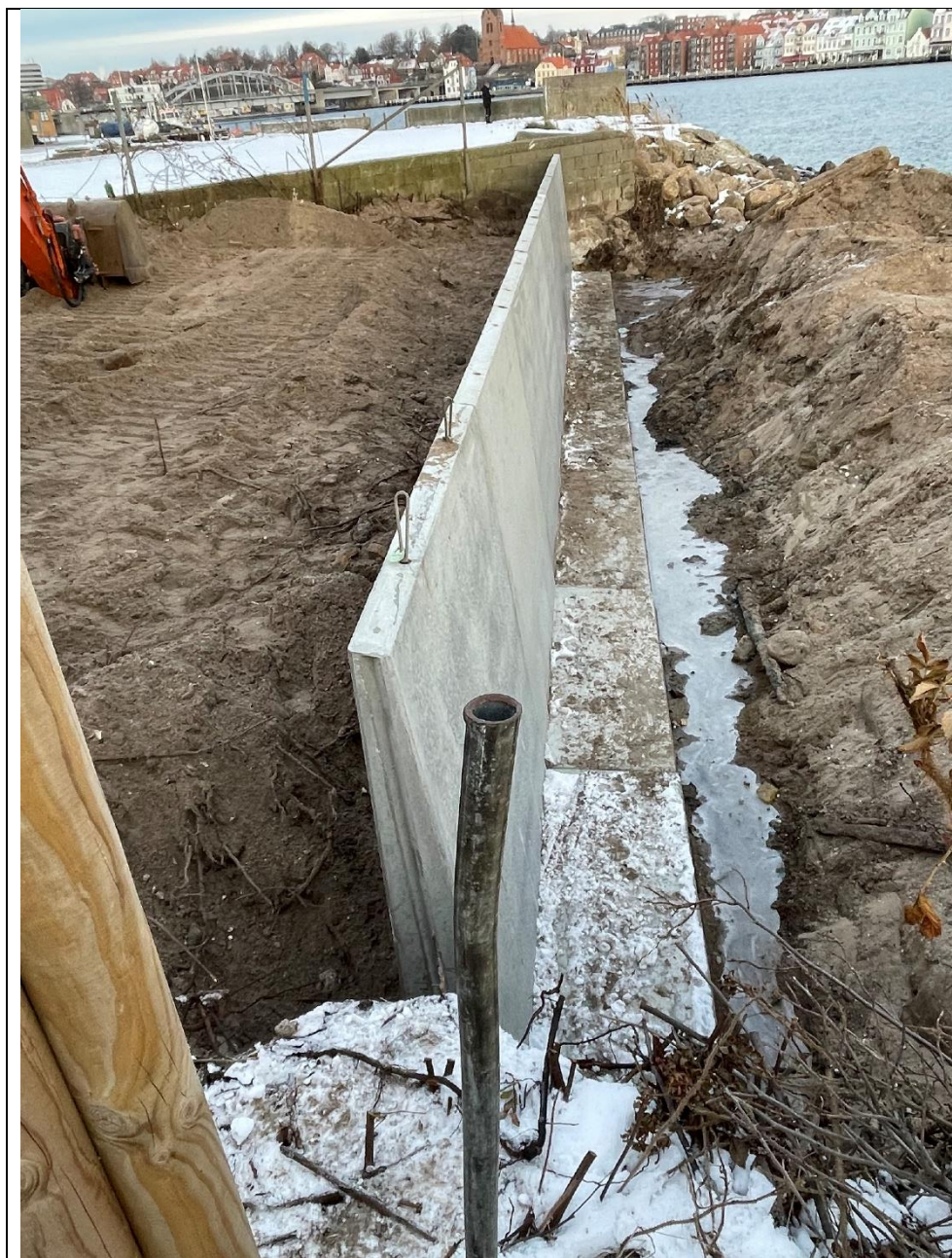
Figur 5: De ønskede L-elementer i beton ses her på nabostrækningen. Se detaljer om L-profiler i Bilag 4.
