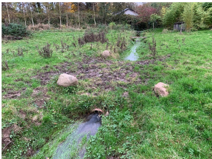
Overgang der ønskes lovliggjort
