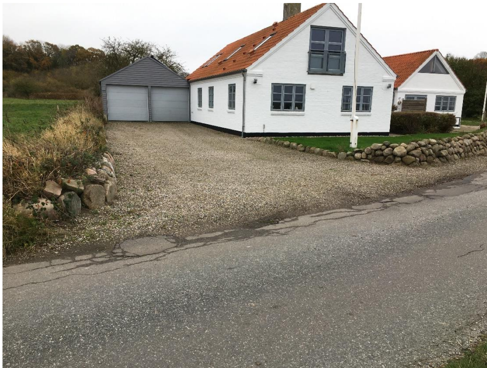
Figur 5 Indkørsel ved nr. 17 (Billede 3573)
