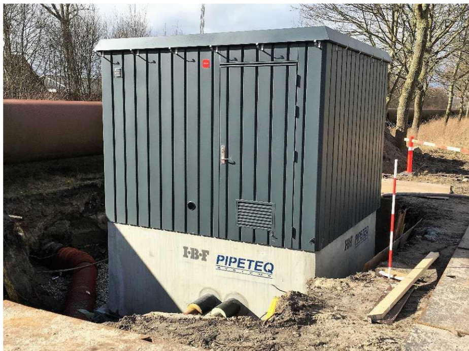
Foto som viser eksempel på shuntstation.
