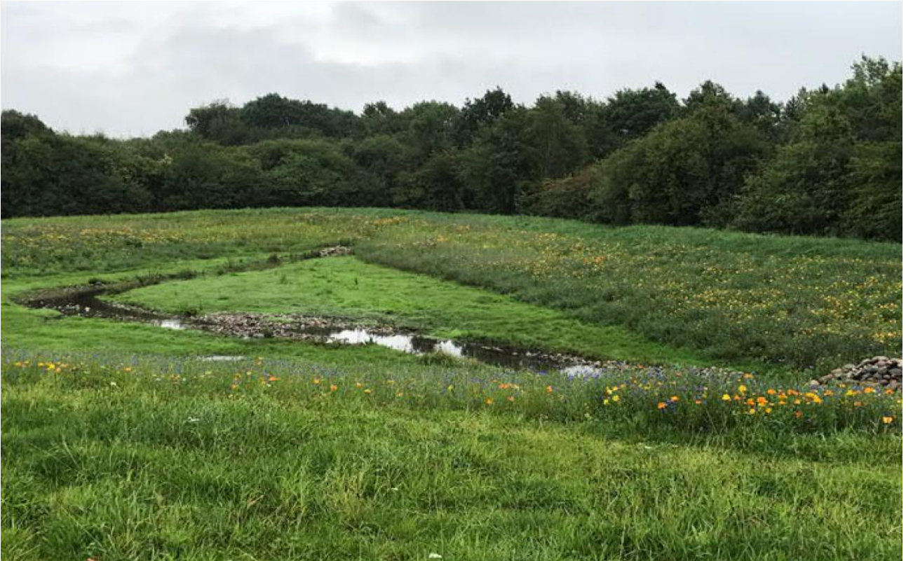
Eksempel på forsinkelsesbassin ved Kollegiehaven i Sønderborg, hvor der er sået engblomster omkring bassinet.
