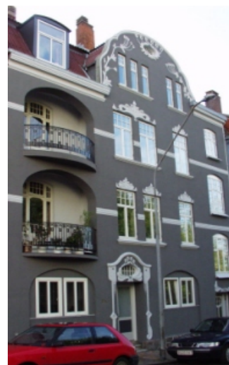
Smukt istandsat bygning. Detaljering og materialer er i overensstemmelse med husets arkitektur (vinduespartiet i stueetagen er renoveret siden).
