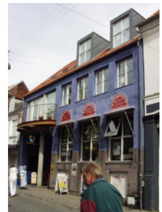
Mindre heldig indpasning. Bygningens elementer og farve afviger fra det eksisterende.
