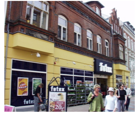
Voldsom skiltning og manglende underetage....
