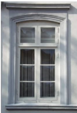
Vindue med koblede rammer og spinkle sprosser.
