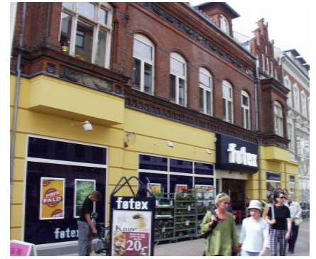
Voldsom skiltning og manglende underetage....
