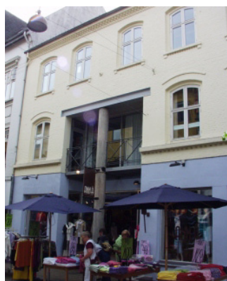
Uheldig renovering, der bryder med husets oprindelige arkitektur på en uheldig måde.
