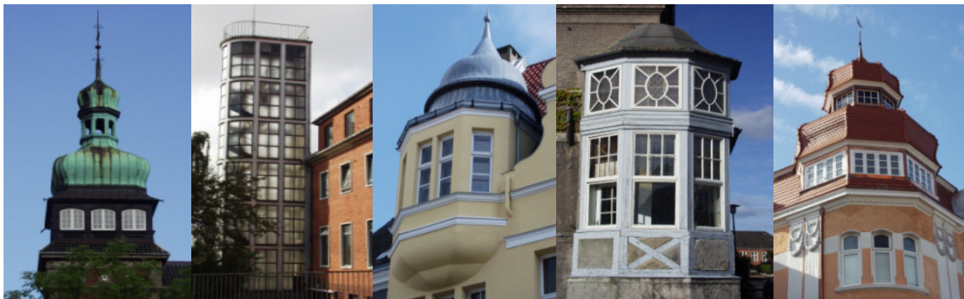
Bygningsdetaljer der alle er vigtige for oplevelsen af arkitektur.
