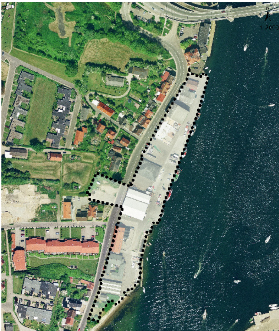
Luftfoto der viser lokalplanområdet
