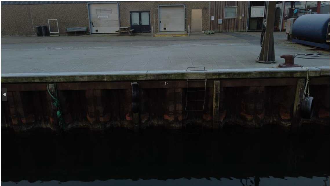
Figur 10: Flere redningsstiger har buler og er bøjet Påsejling
