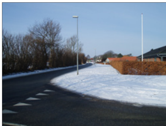
Lambjergskovvej, set fra krydset med Rojgårdsvej. Her kommer den nye stamvej til at blive koblet på.
