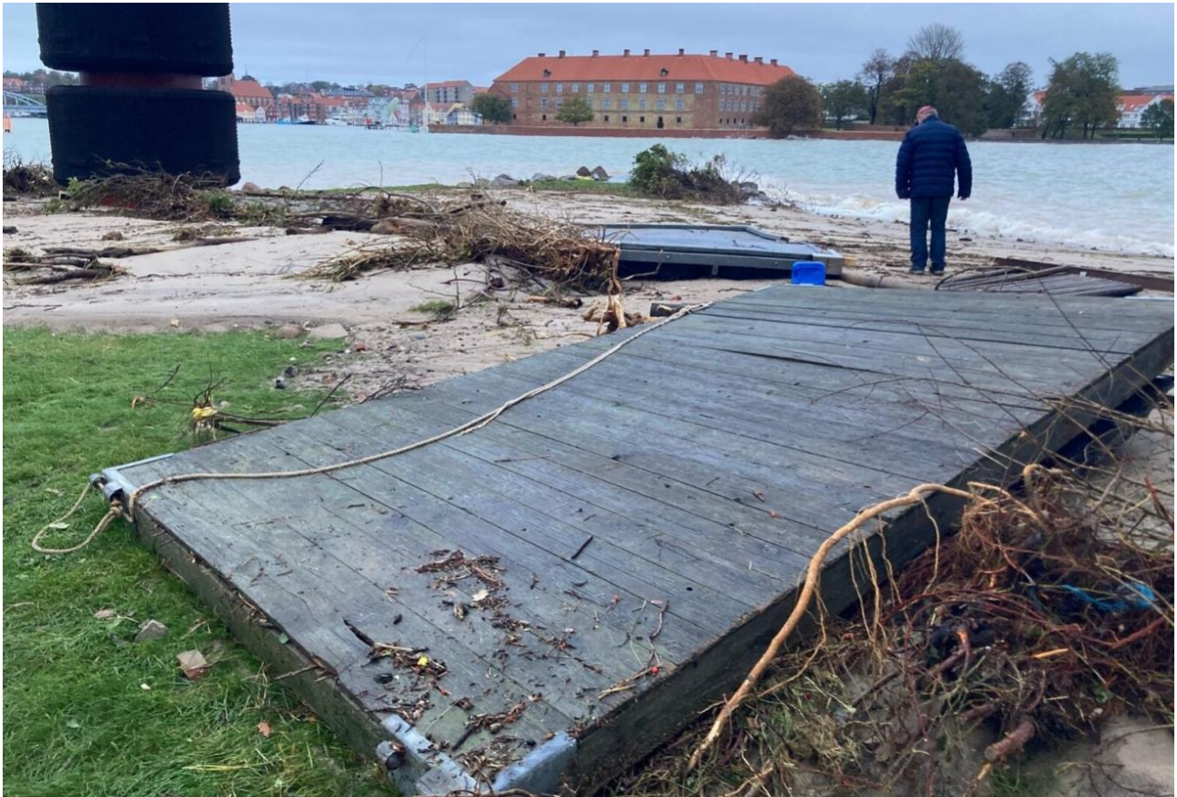
Figur 4.15: Bølgerne har transporteret lidt af hvert med sig under stormfloden. Dagen derpå d. 21. oktober 2023 om morgenen ved Tøren.
