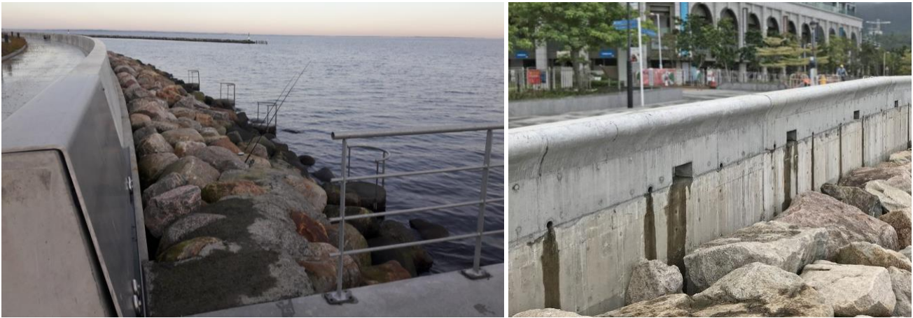
Figur 7.14: Højvandsmur med sten på forsiden tv. og med 'næse' til højre.
