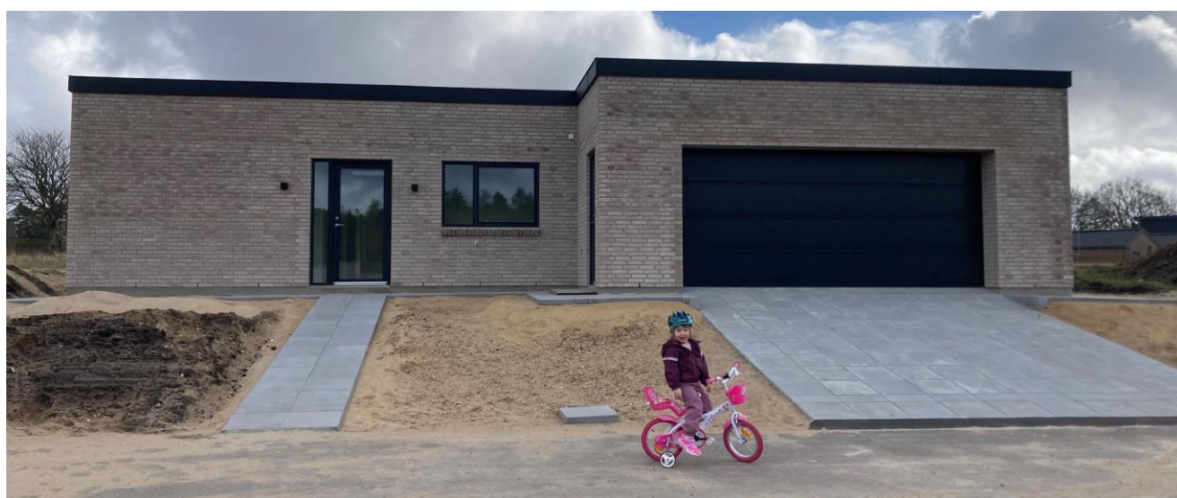
Figur 7.7: Eksempel på terrænhævning.
