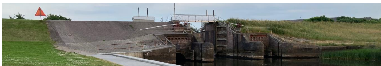
Figur 7.9: Eksempel på sluse/dæmning.
